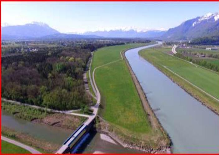
Durch die geplante 3 bis 5 fache Verbreiterung der jetzigen Flusssohle, wird die Fließgeschwindigkeit langsamer und es wird vermehrt zu Auflandungen von Schlick und Schwemmholtz kommen!
