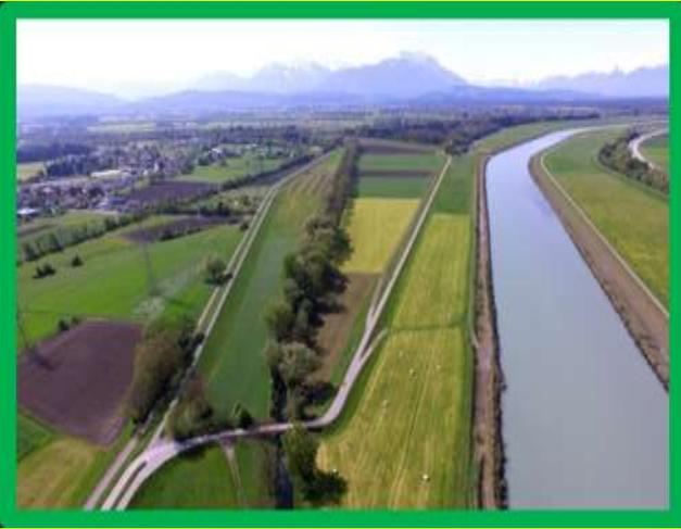
Der bestehende Querschnitt im Projektabschnitt 1 ist so groß und die Dämme so hoch, dass 4300 m<sup>3</sup>/s Wasser mit einem Freibord von 1 m in diesem Abschnitt abgeleitet werden können!
